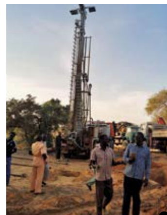
Derrick de forage à 180 m
