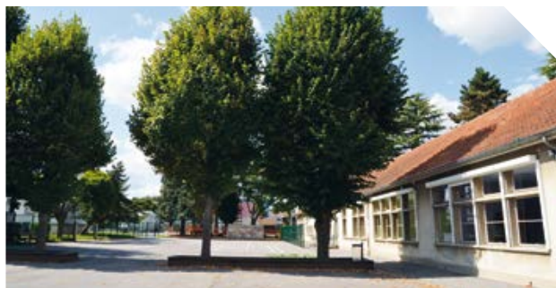
⑨ ÉCOLE ÉLÉMENTAIRE DE MONDÉTOUR : ravalement du bâtiment A , façade sud
