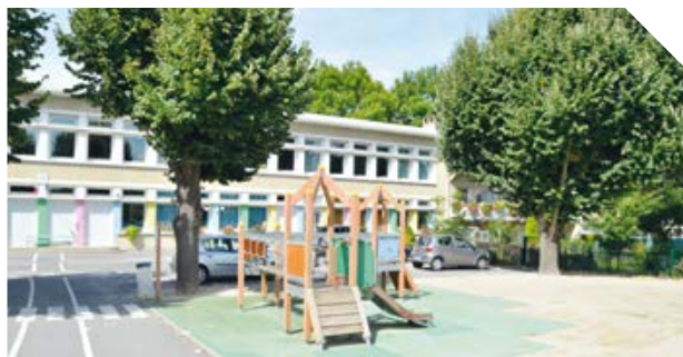
⑩ ÉCOLE MATERNELLE DU GUICHET : remplacement du sol à l'étage
