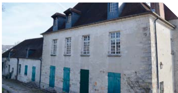
⑫ LA BOUVÊCHE : peinture intérieure du rez-de-chaussée
