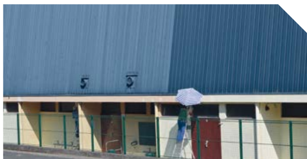
⑪ GYMNASSE BLONDIN : réfection du mur du local de stockage
