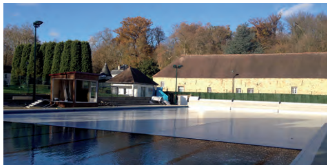
La nouvelle couverture du bassin nordique.
