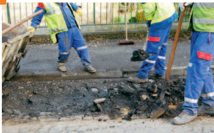
22 janvier - Rebouchage des nids-de-poule route de Montlhéry.
