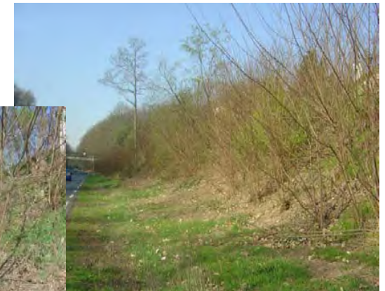
Résultat travaux 2009 (n+2)
