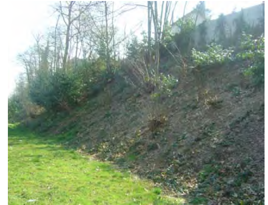
Résultat travaux 2010 (n+1)
