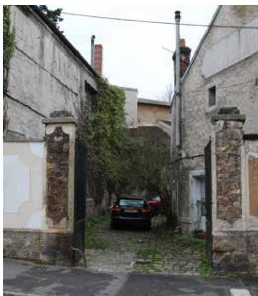
Accès à la cour intérieure
