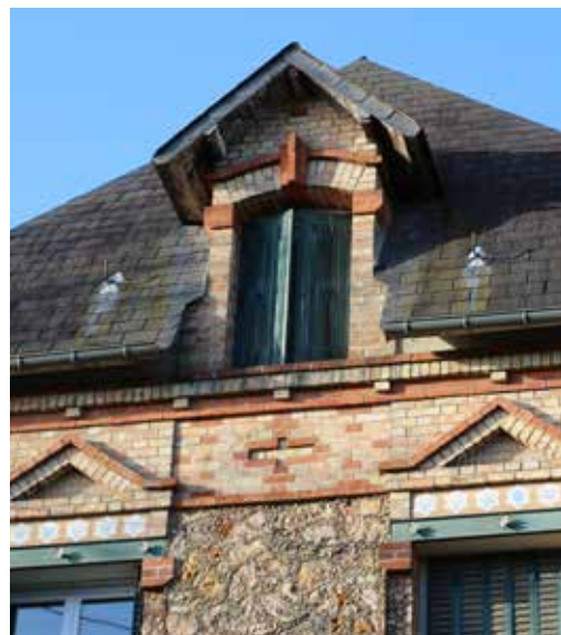
Détail de la façade
