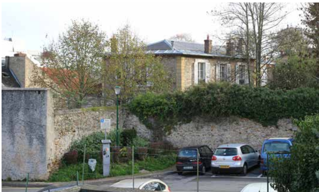
Vue depuis la terrasse du bâtiment de la parcelle n°150
